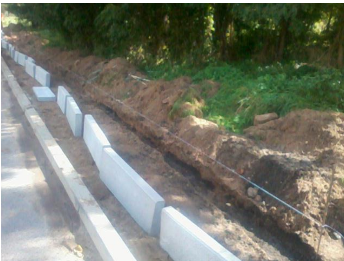
Fot. 2 Zadanie w trakcie realizacji
