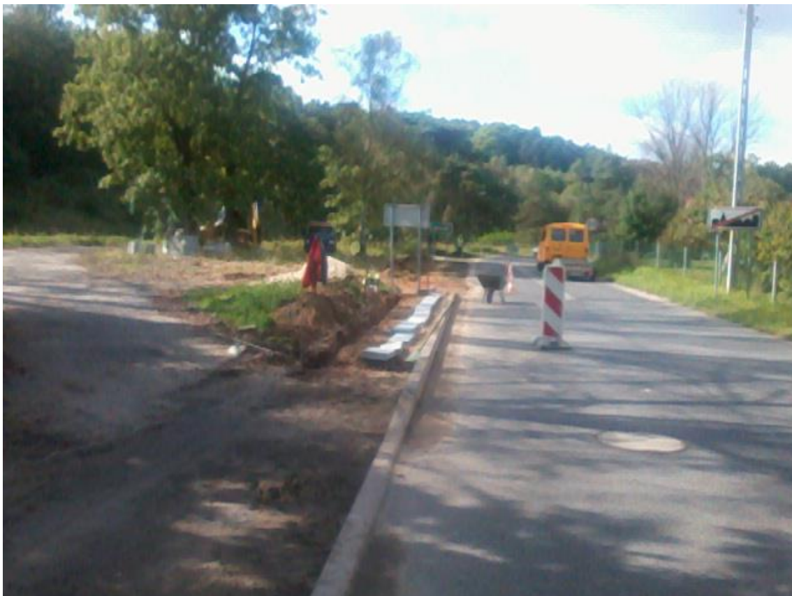
Fot. 3 Zadanie w trakcie realizacji
