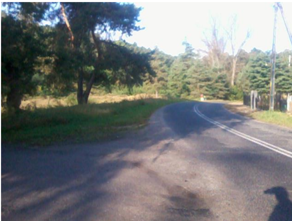
Fot. 1 Widok drogi powiatowej przed wykonaniem chodnika
