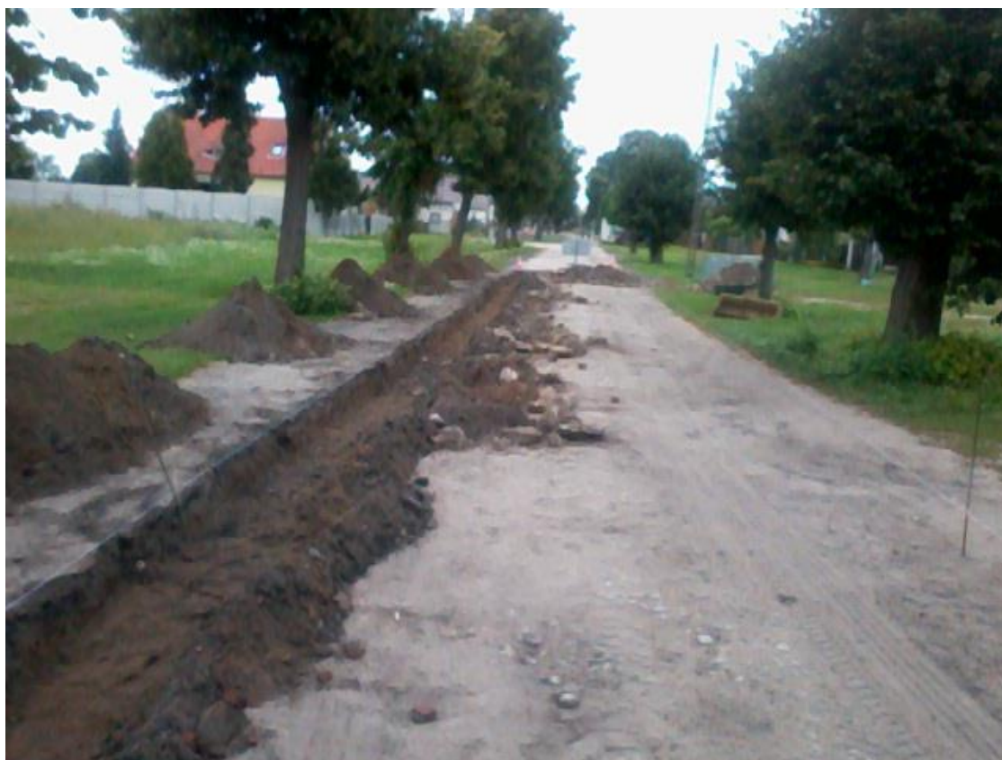
Fot. 2 Widok drogi powiatowej nr 1024F w trakcie modernizacji
