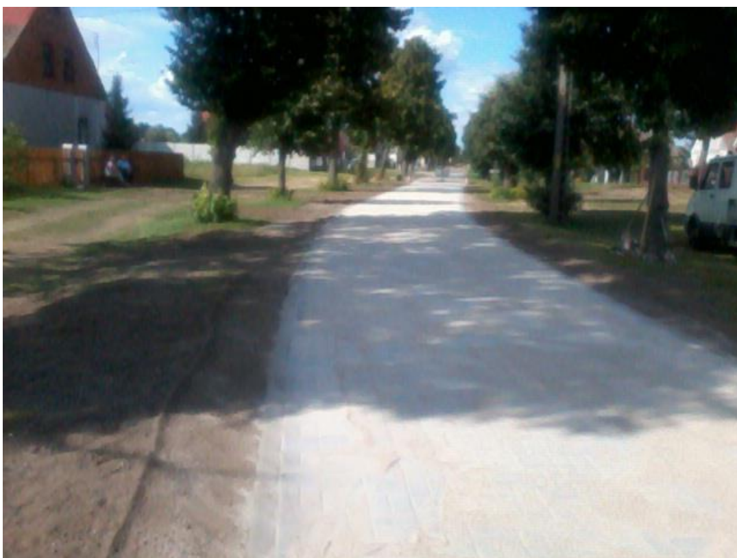
Fot. 4 Widok drogi powiatowej nr 1024F po wykonaniu modernizacji
