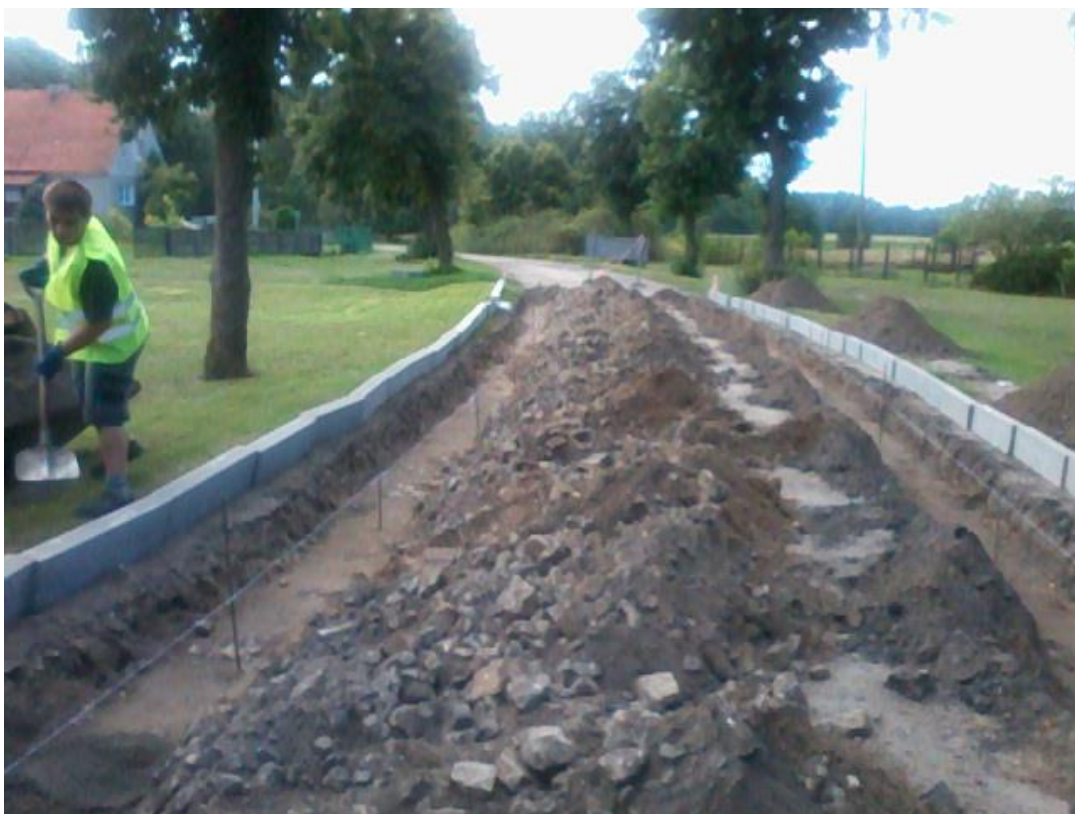
Fot. 3 Widok drogi powiatowej nr 1024F w trakcie modernizacji
