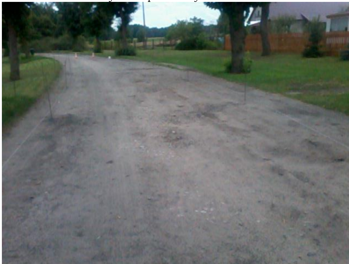
Fot. 1 Widok drogi powiatowej nr 1024F przed modernizacją
