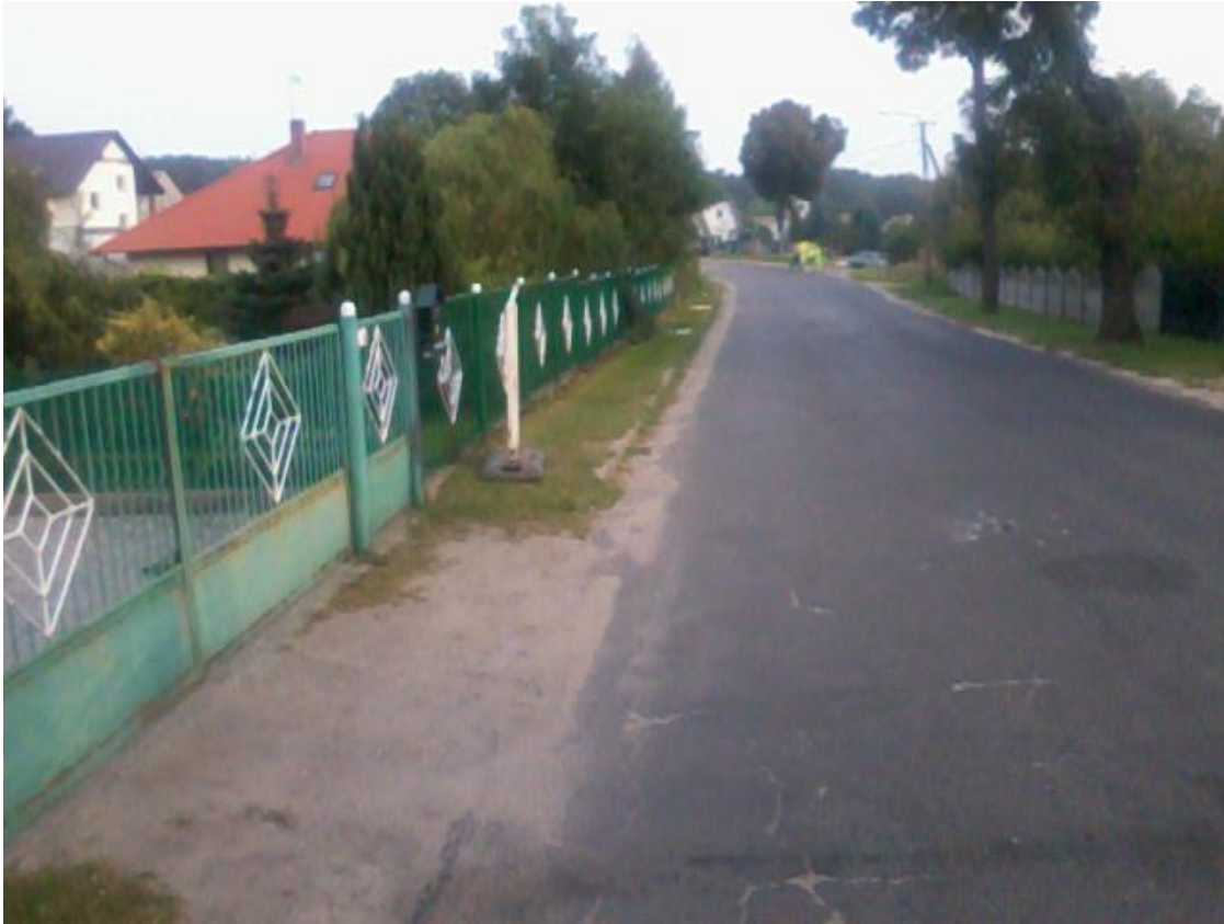
Fot. 1 Widok drogi powiatowej przed wykonaniem chodnika
