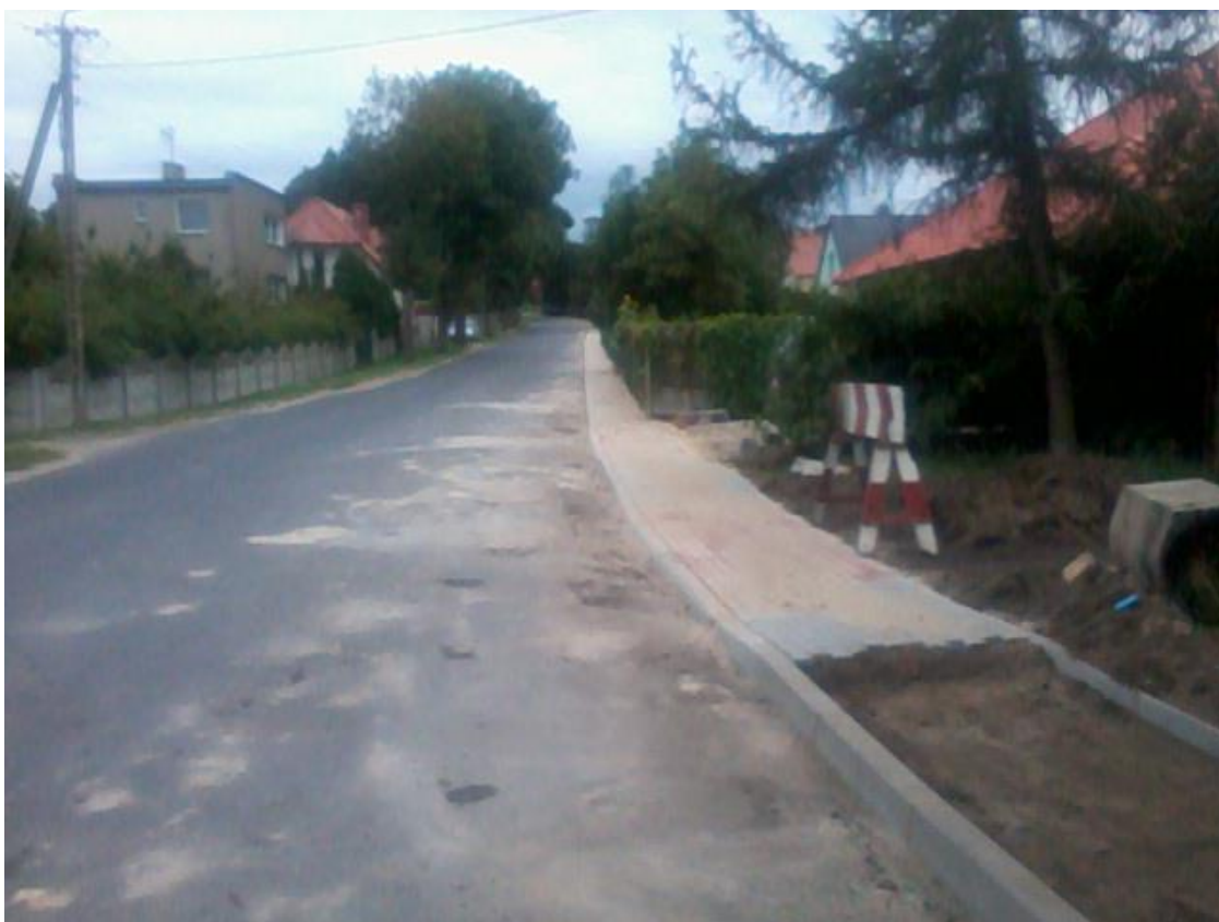
Fot. 4 Zadanie w trakcie realizacji
