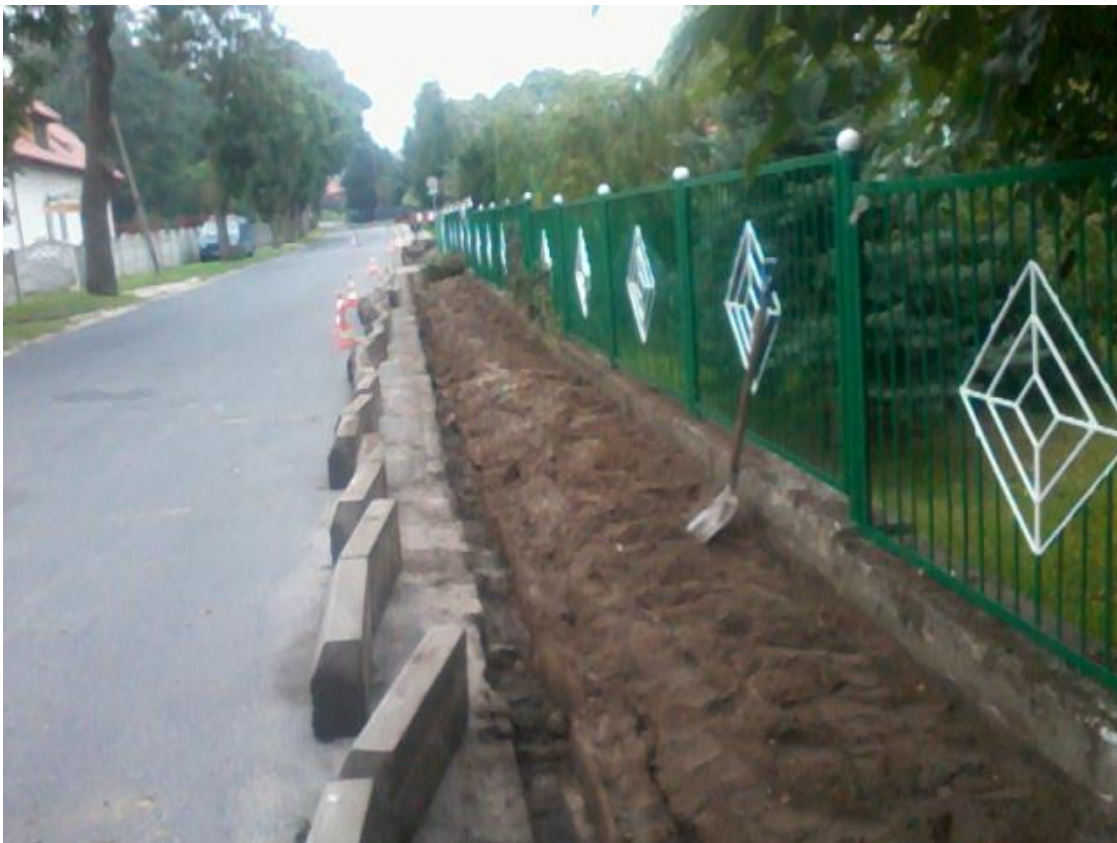
Fot. 2 Zadanie w trakcie realizacji
