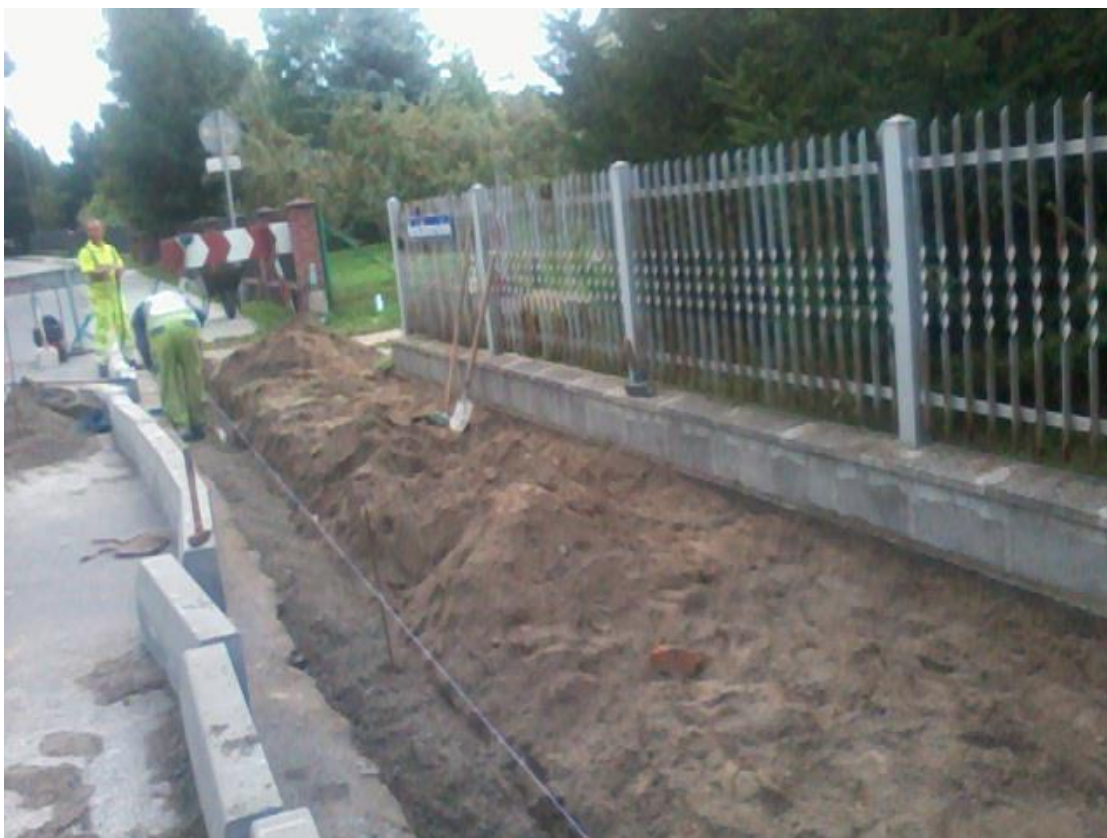
Fot. 3 Zadanie w trakcie realizacji
